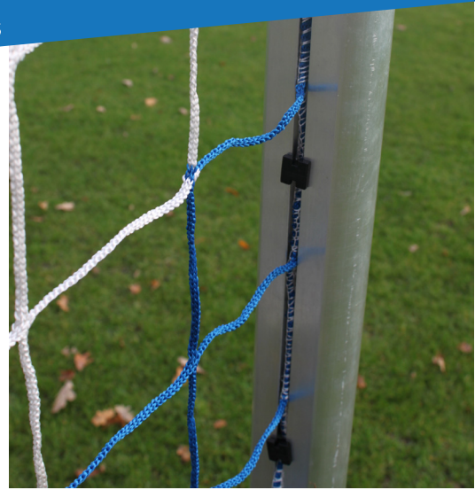
Afgebeeld is de netbevestiging dmv netplaatjes in brut aluminium profiel.
